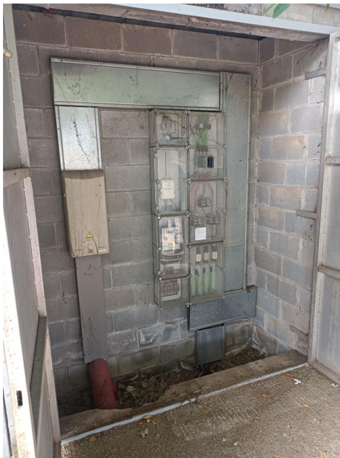
Imatge 7. Armari de comptadors i quadres
