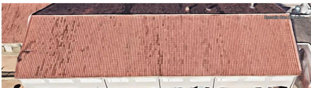
Imatge 5. Coberta sobre teula.
