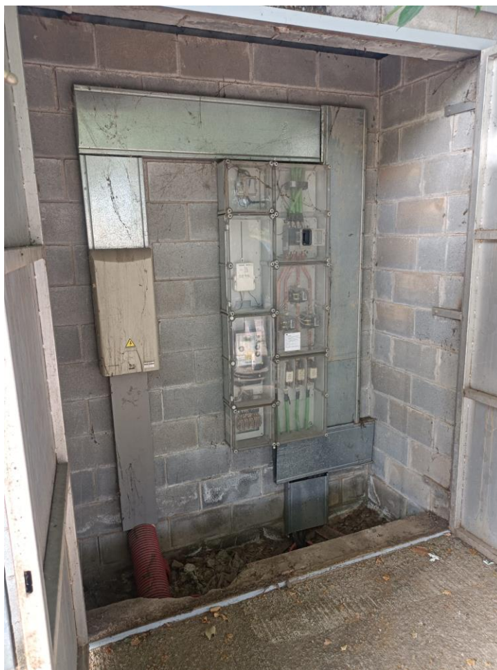
Imatge 23. Armari de quadres i comptadors.
