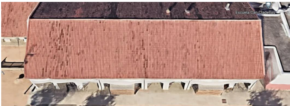
Imatge 21. Coberta sobre teula.
