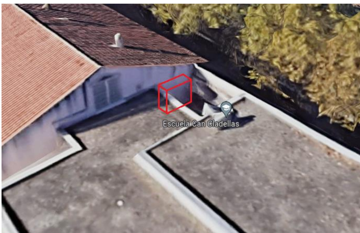
Imatge 22. Ubicació de l'inversor i equips fotovoltaics.
