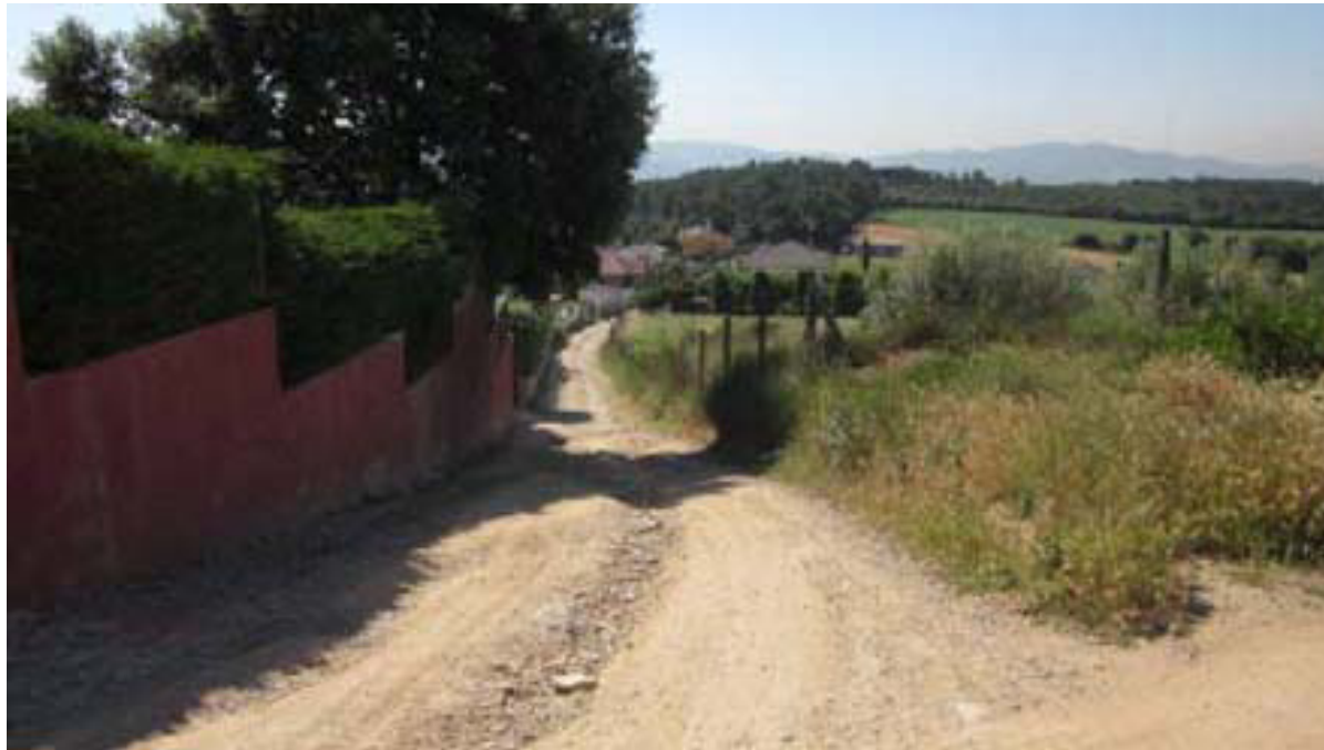
Imatge 12. Tram inicial camí terra. Zona urbanitzada
