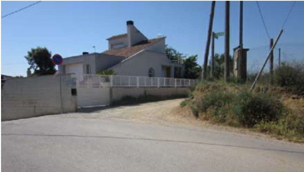
Imatge 10. Inici del tram de terra
