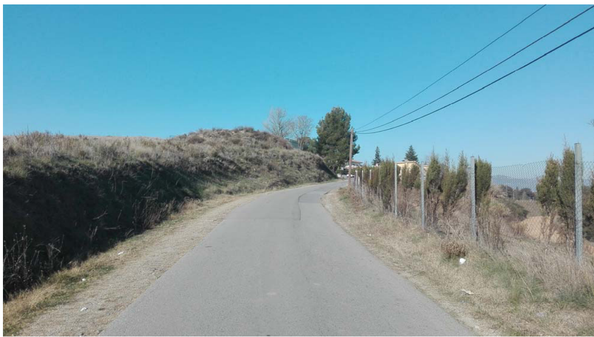
Imatge 4. Tram asfaltat inicial. Vista al Dipòsit
