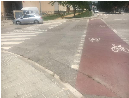
Imatge 15. Carril bici mal pintat amb el pas de vianants.
