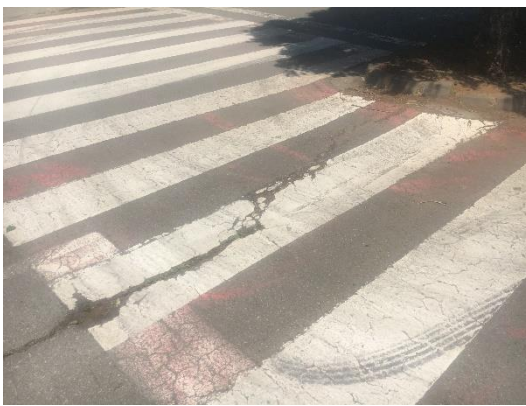
Imatge 19. Passos de vianants en mal estat i mal pintats.
