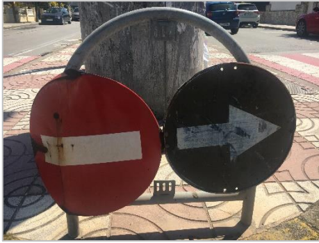
Imatge 37. Senyals antigues en mal estat.
