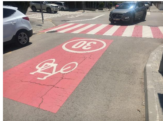
Imatge 22. Reforç al pas de vianants amb vermell al entrar en una zona 30.
