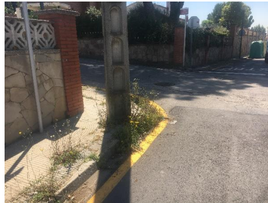
Imatge 10. Prohibició d'aparcament només a les cantonades i manca de pas de vianants.
